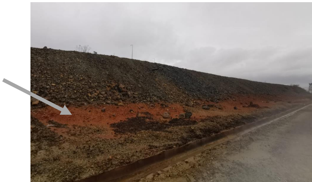
Figura 1 - Vista da impermeabilização efetuada na base- Aterro Temporário de feitos
