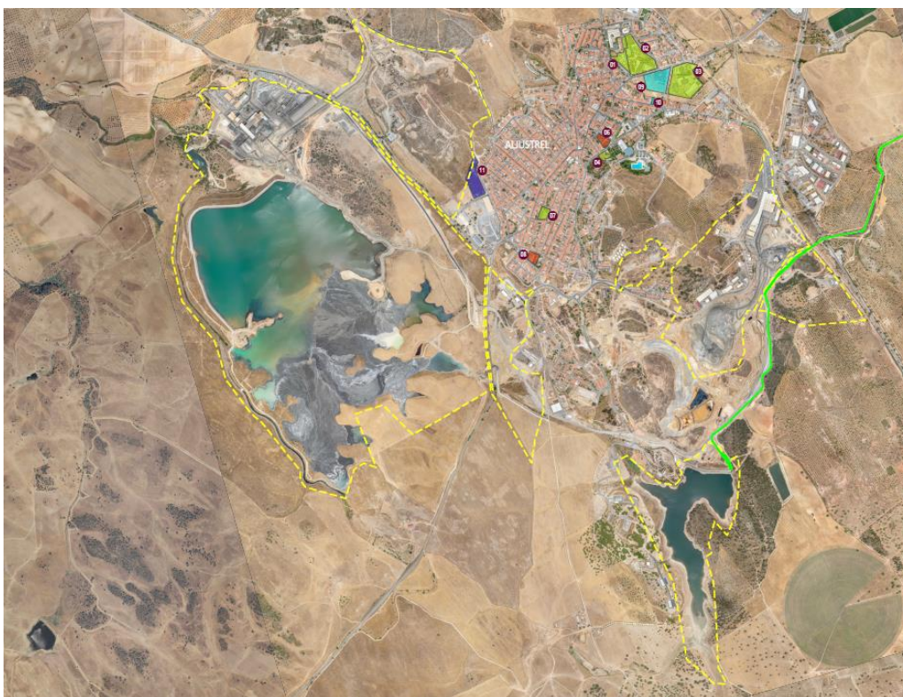
Figura 17 - Vale a jusante da BAI
